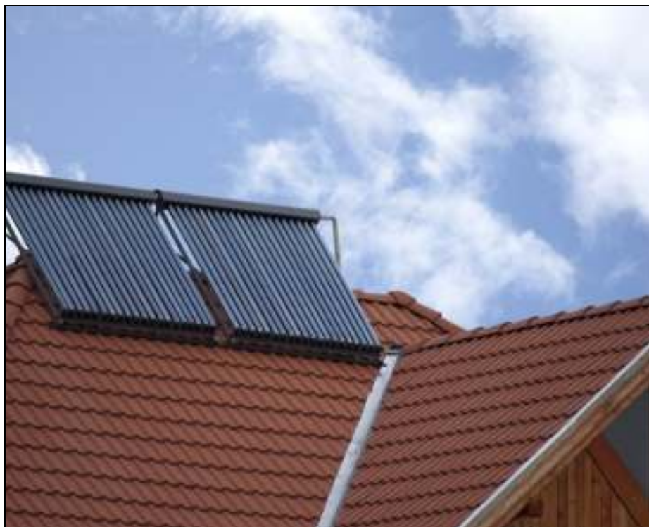
Rysunek 7. Kolektory słoneczne (źródło: http://www.brewa.pl/produkty-i-uslugi/kolektory-sloneczne-intro.html )
