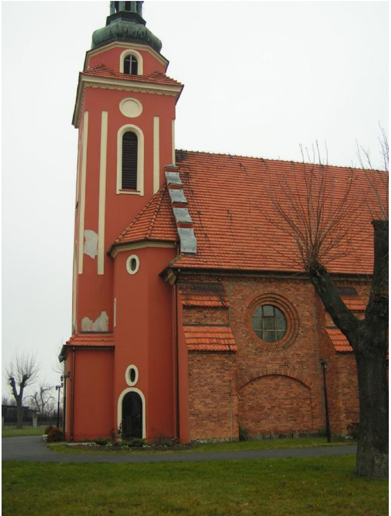
Zdjęcie nr 1 – elewacja wschodnia.
