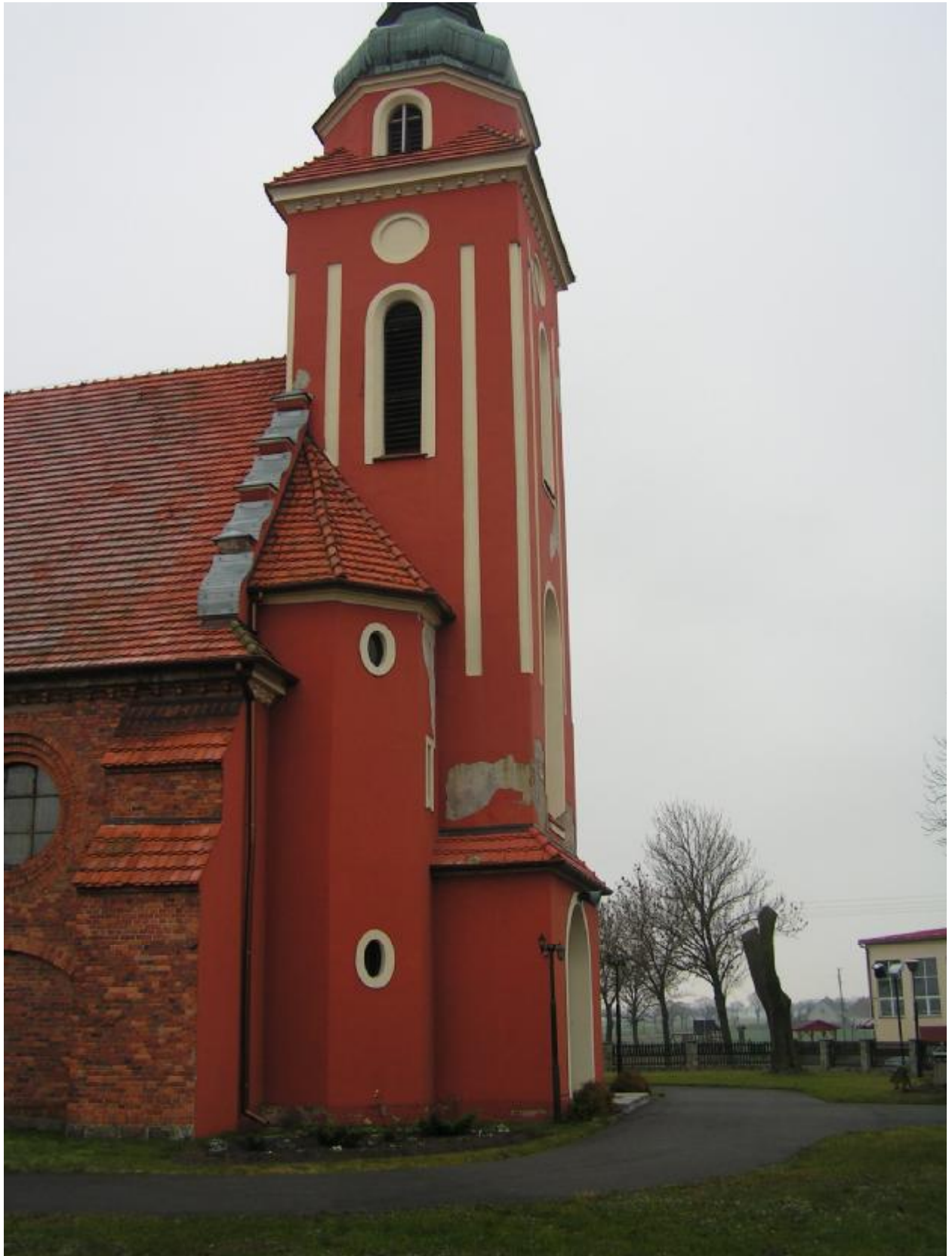
Zdjęcie nr 3 – elewacja zachodnia.
