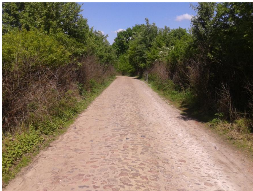
Zdjęcie nr 1 istniejąca droga gminna
